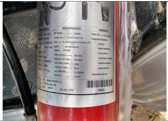
Foto 16: Veículo de placa KHJ-4930, extintor com validade vencida, Chã Grande (PE), 8 de julho de 2015.
